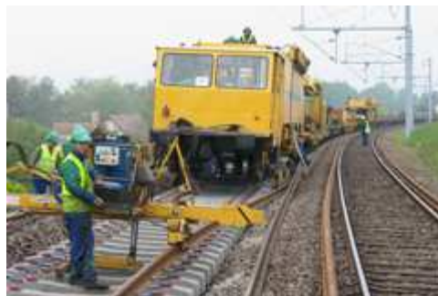
Longs Rails soudés sur traverses béton
