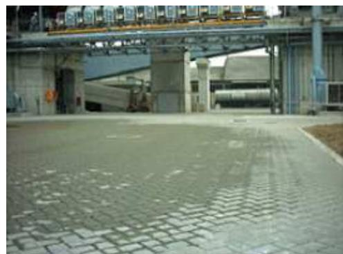
Figure 41 – Vue de la zone réalisée en pavé dépolluant à base de ciment « TX Active® » (25)
