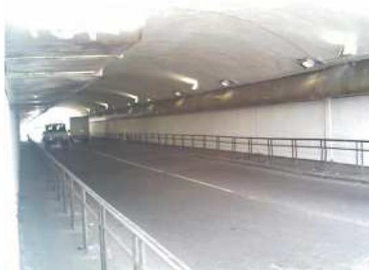
Figure 43 – Chaussée réalisée en ciment « TX Active® » dans un tunnel près de Milan (25)
