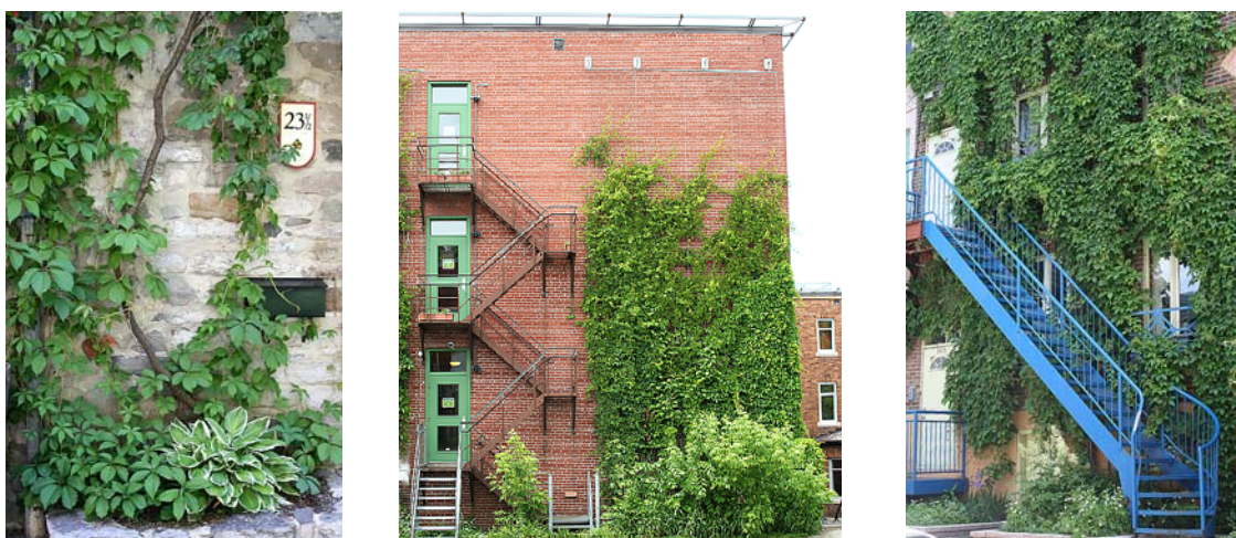
Figure 4 Murs végétaux de façade
